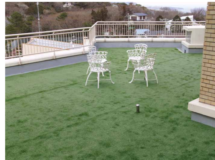
ベランダ施工例
