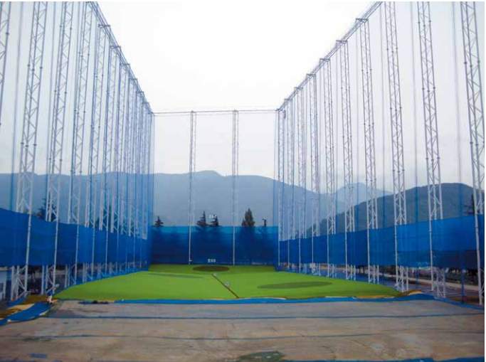
ゴルフ練習場施工例
