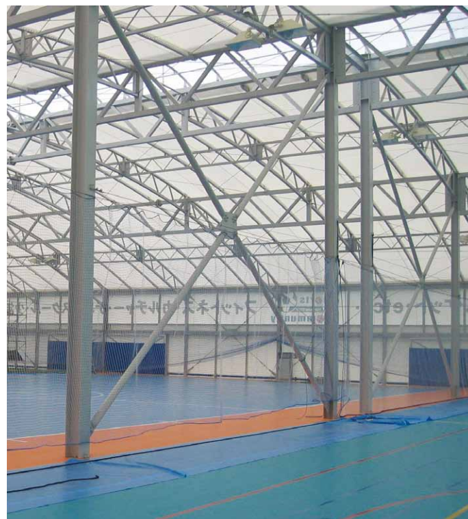
室内球技場施工例
