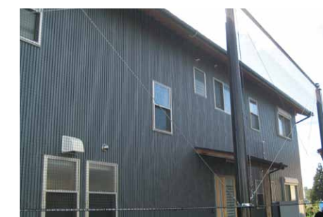
個人邸枯れ葉防止ネット施工例
