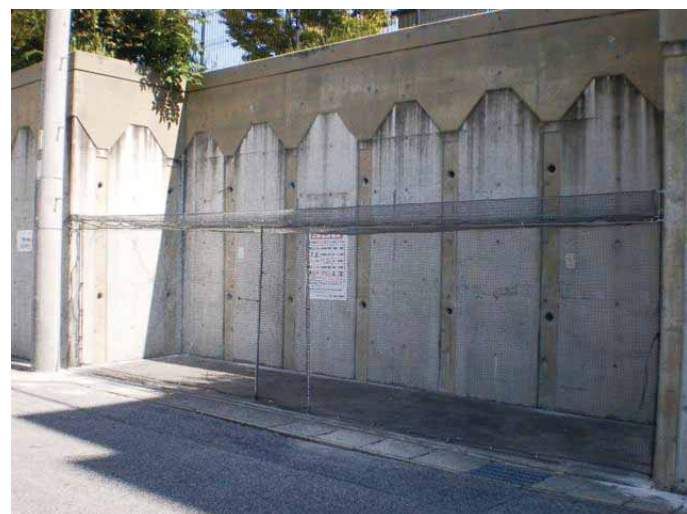
マンションゴミ置場施工例
