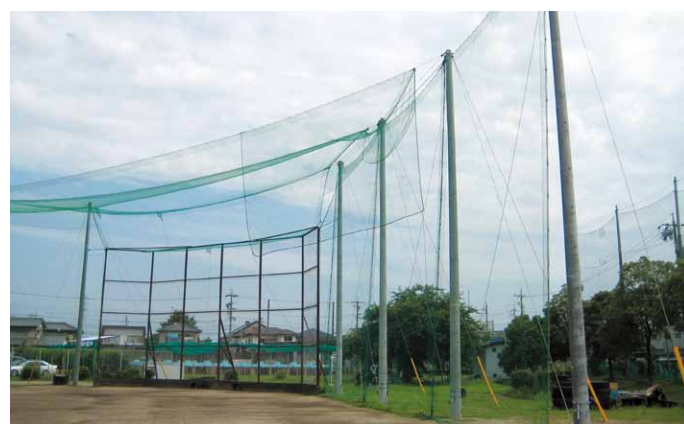
野球グラウンド施工例
