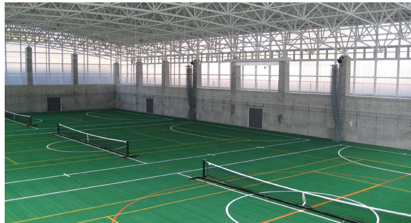
室内球技場施工例
