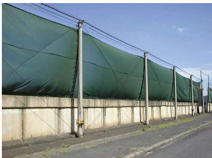
遮光・防風・防塵施工例
