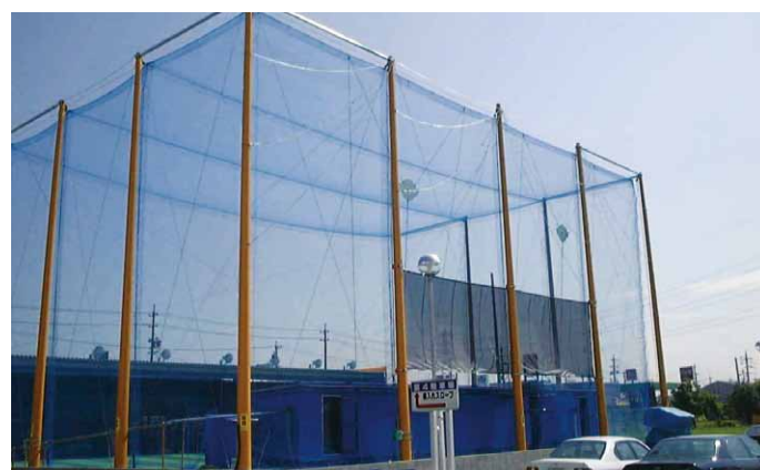
バッティングセンター施工例
