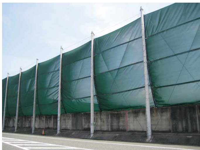
防砂・遮光ネット施工例
