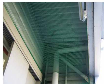
工場軒下施工例
