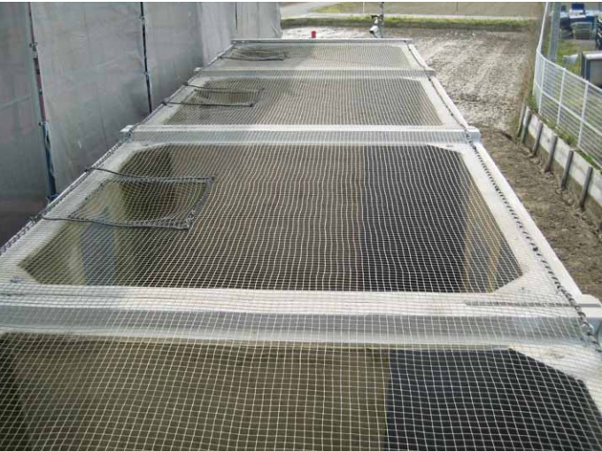
消化水槽施工例
