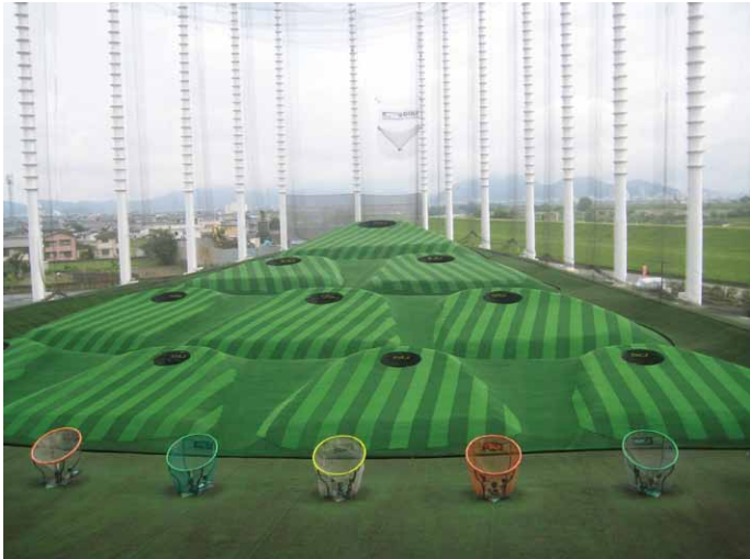
ゴルフ練習場施工例
