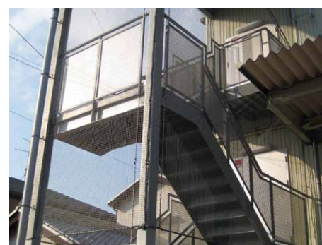
外部階段施工例
