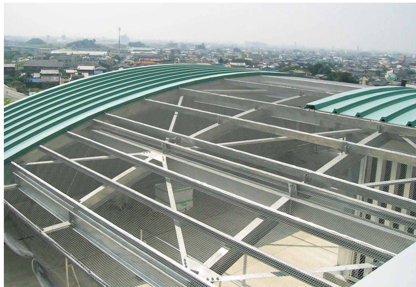
屋上屋根施工例
