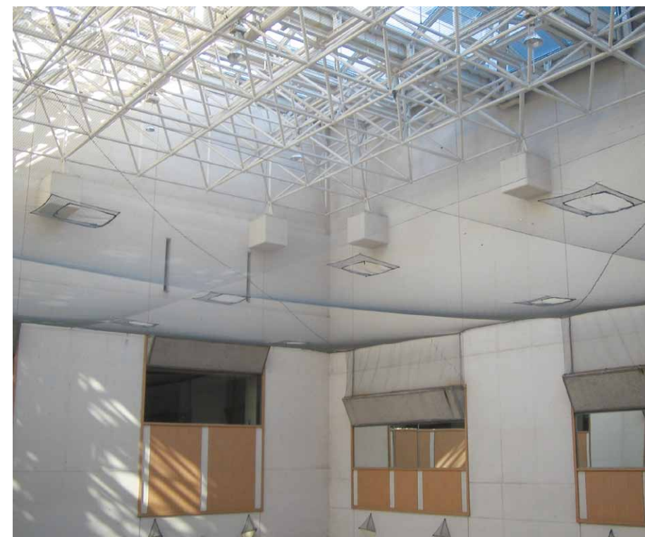
駅構内施工例
