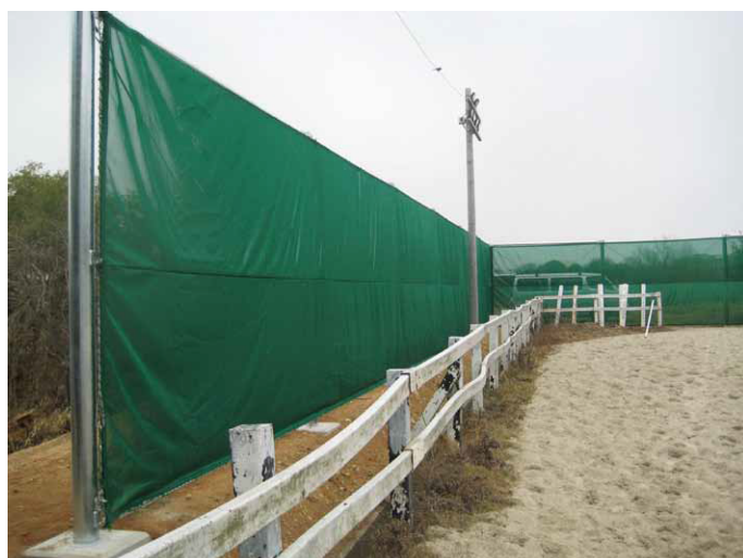
遮光・防風・防塵施工例
